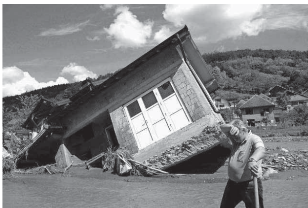
Slika 2. Posledica poplave i klizišta
