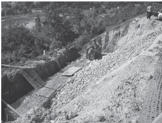
Slika 2. Sanacija klizišta „Gradina“ u Tuzli
