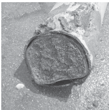
Slika 11: Voda u kablu sa papirnom izolacijom
