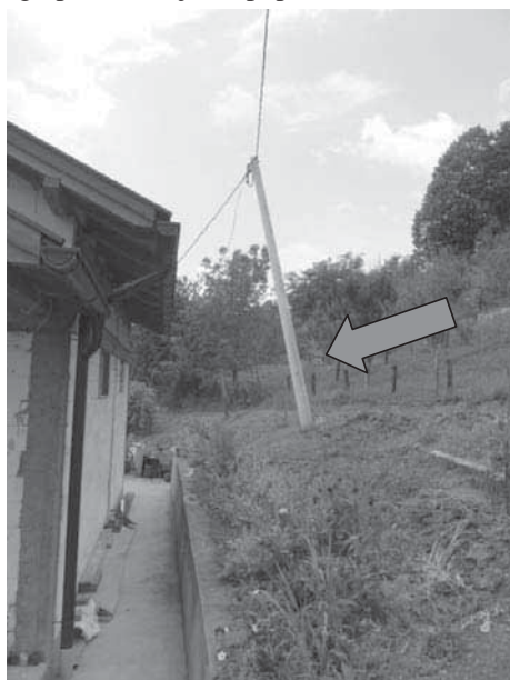
Slika 14. Djelovanje klizišta na električni stub, klizište Grabovica – Tuzla, maj 2014. godine
