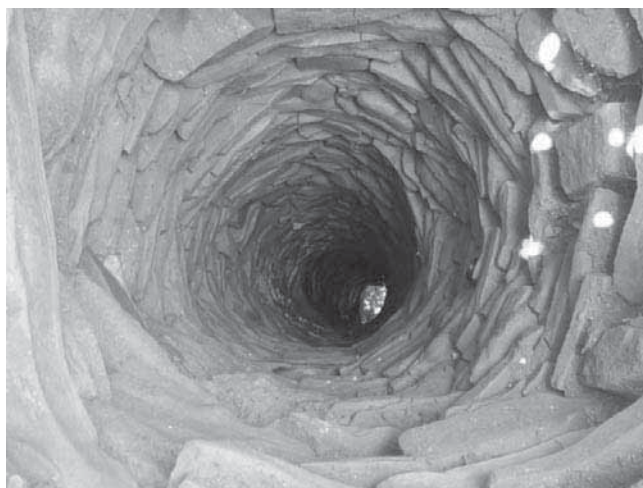
Slika 16. Devijacija bunara na 5 m dubine, klizište Tetima – Tuzla, maj 2014. godine
