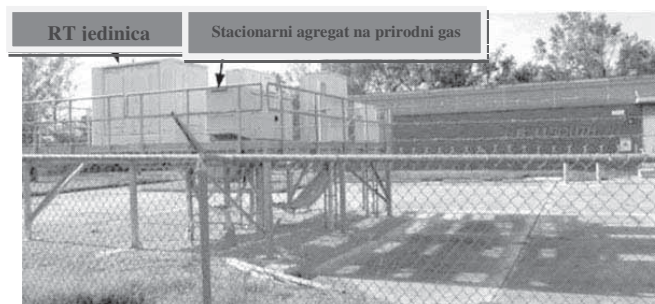
Slika 5: RT jedinica i stacionarni agregat sa dotokom prirodnog gasa
