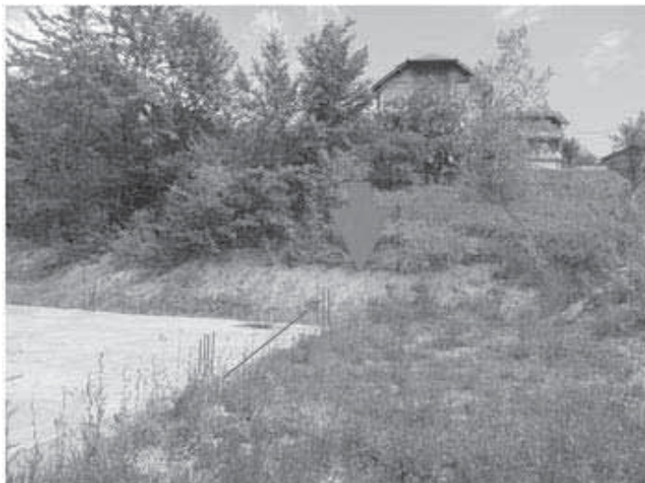
Slika 9. Zasjećanje padine kao trigger destabilizacije – Vogošća (foto: T. Nikolić, maj 2014.)
