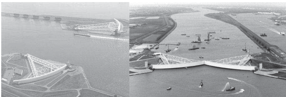
Slika 10. Pokretna pregrada Maeslantkering otvorena i zatvorena
