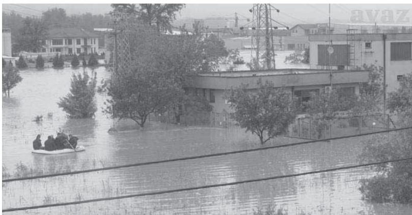
Slika 3 – Trafo stanica sagrađena u plavnom području rijeke Spreče u Gračanici
