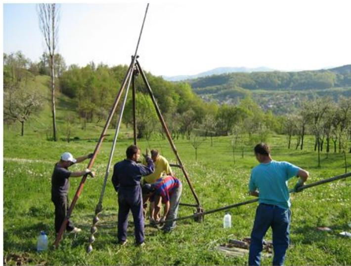
Slika 4. – Dolapska garnitura za bušenje geomehaničkih bušotina
